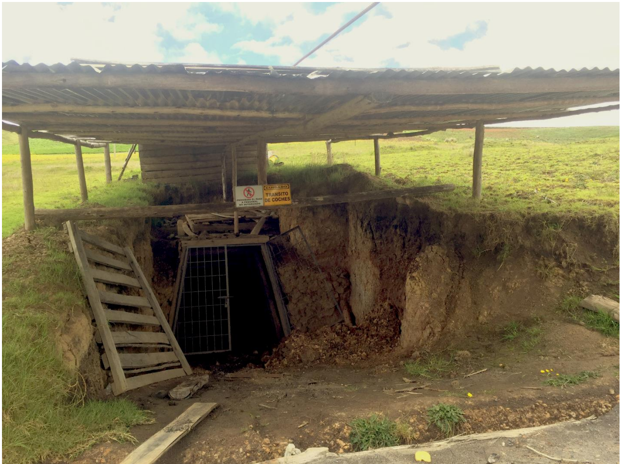
Imagen 2- entrada a la bocamina.
